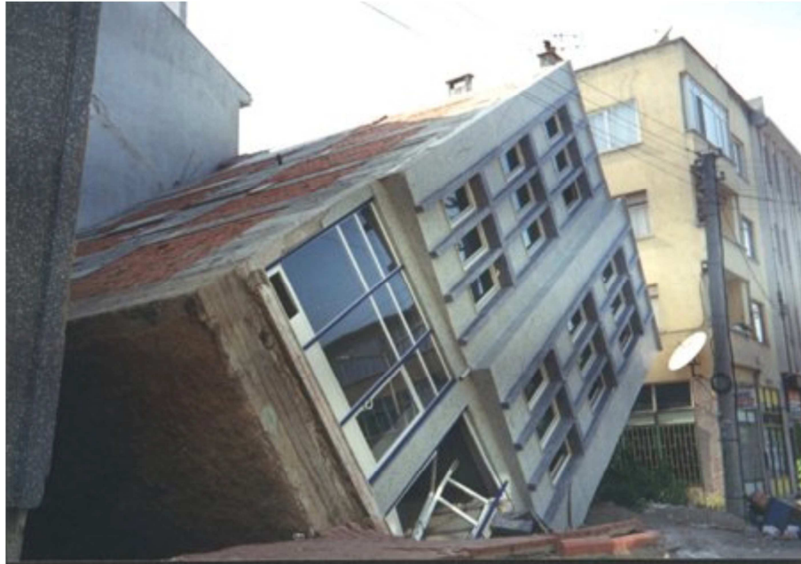
Kocaeli Depreminde Zemin Sıvılaşması Sonucu Devrilen Bir Bina
